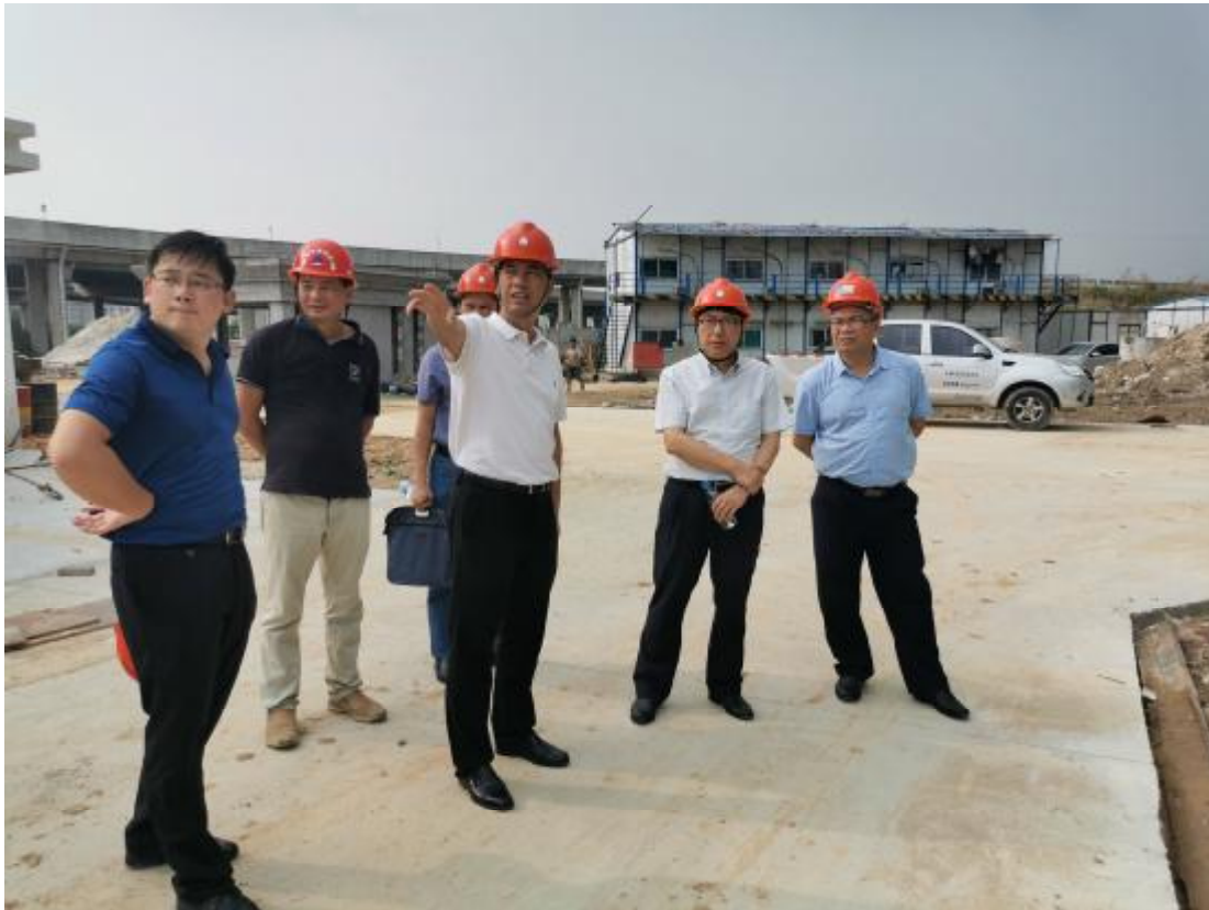
检查督促乐平二厂施工现场
