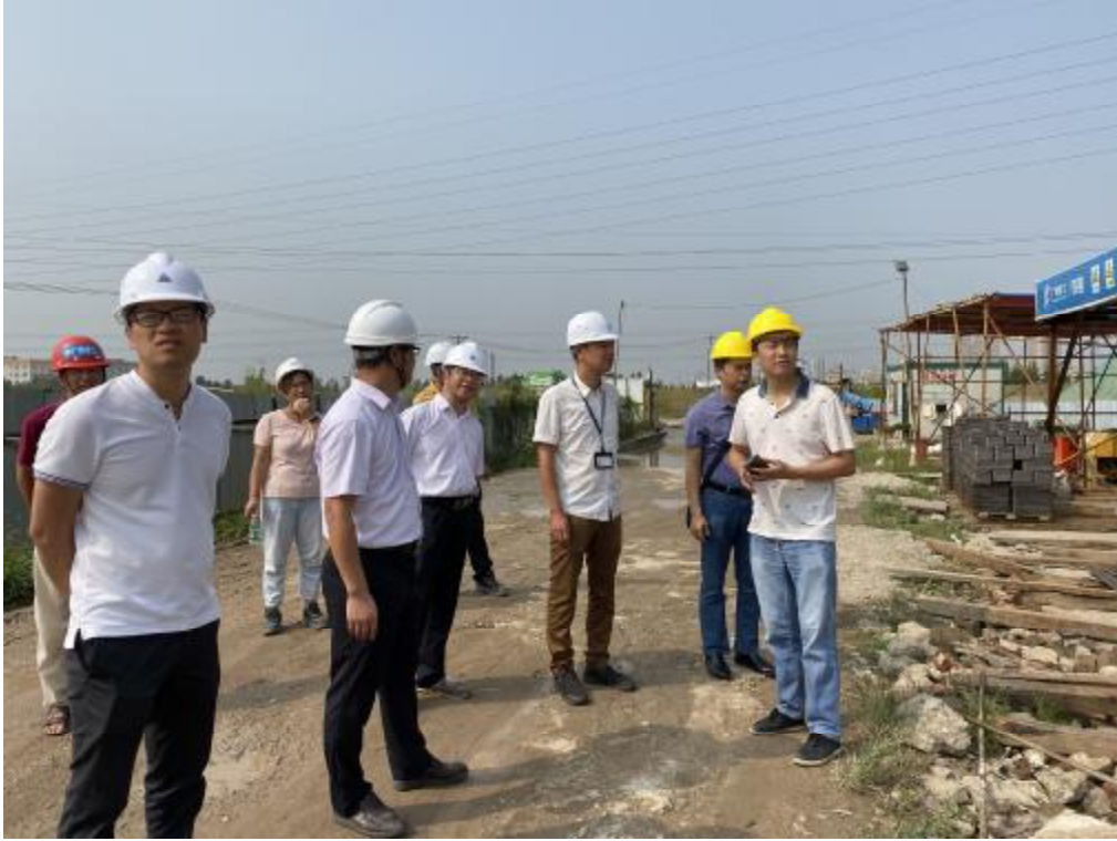
市住房城乡建设局和市生态环境局联合检查群力围污水厂
