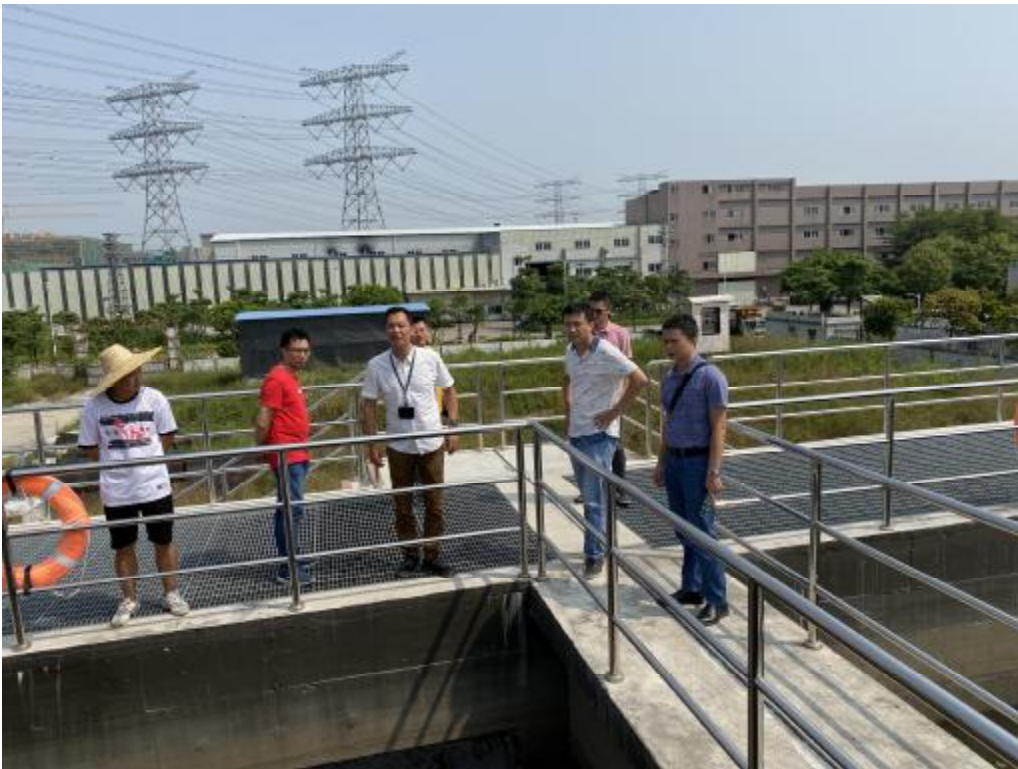
均安污水厂二期正在进水试运行中
